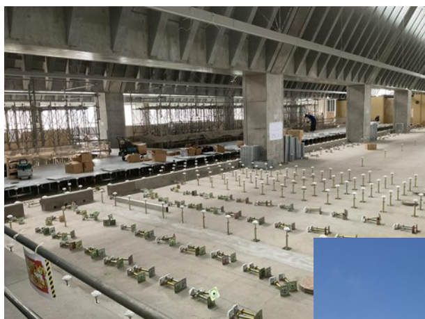
▲0Aフロアの設置
