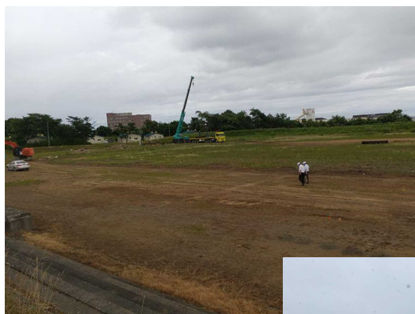
▲工事着工当初の様子 (令和6年7月24日時点)
