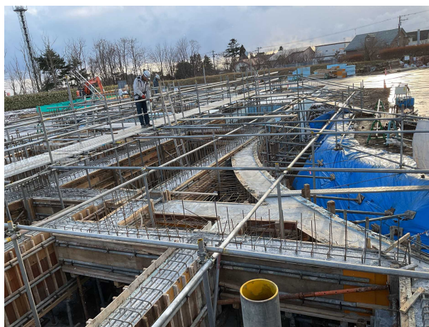
▲工事現場（正面玄関周辺）の様子 （令和6年12月4日時点）
