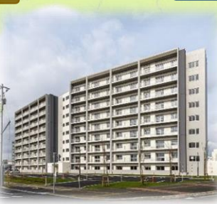
道営住宅 （旭川市であえーる宮下東）
