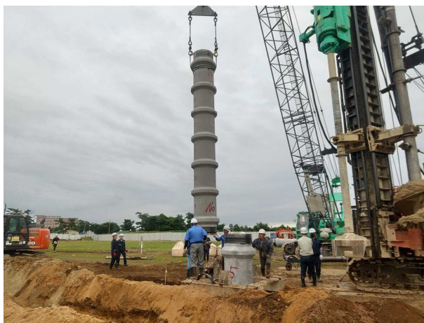
▲杭打ち工事の様子 (令和6年8月5日時点)
