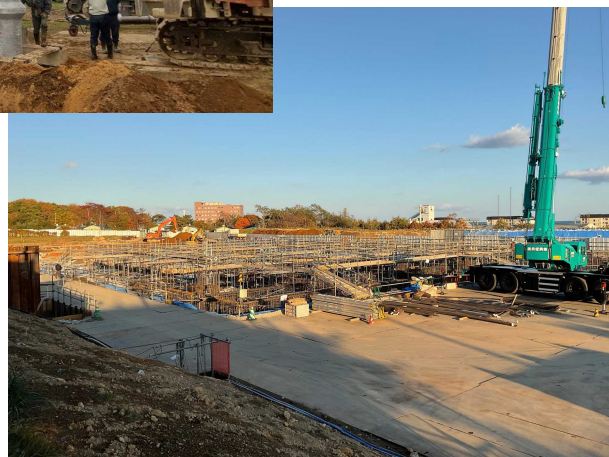
▼配筋工事の様子 (令和6年10月31日時点)
