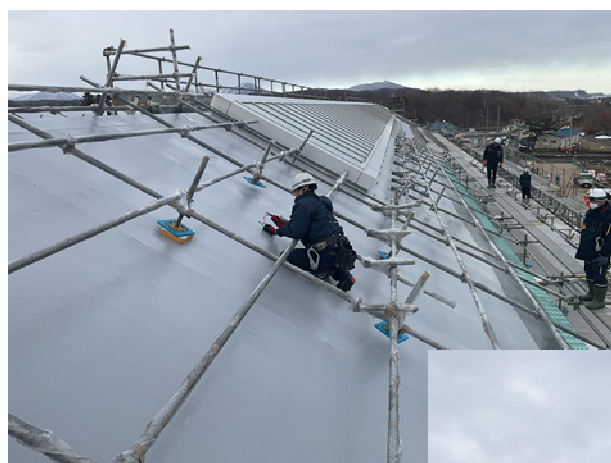
▲屋根検査の様子
