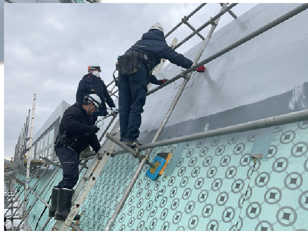
▼屋根検査の様子
