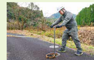
安全で安心な水を届けるために、現場での点検や作業にあたります
