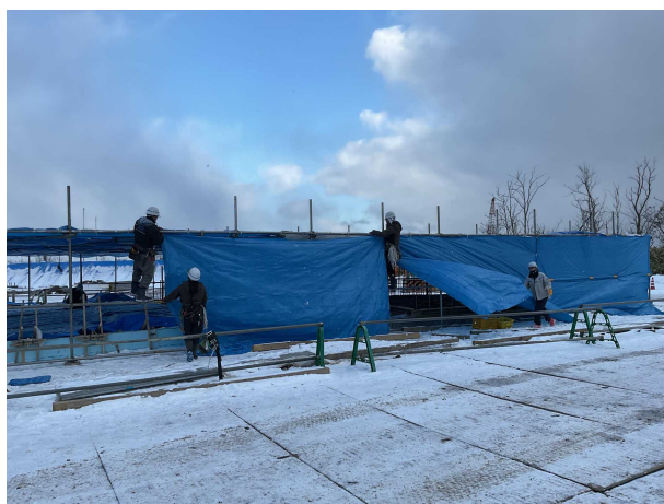
▲工事現場（防寒養生）の様子 （令和6年12月17日時点）
