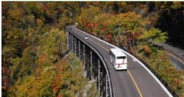
道路網の整備や道路の防災対策、老朽化対策、交通安全対策などの道路整備を行う。
