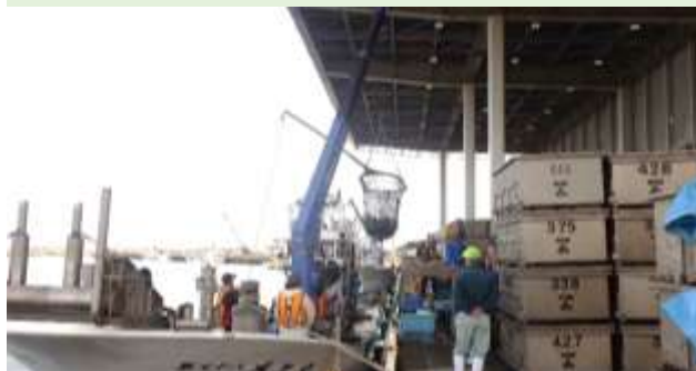
安全安心な水産物を供給するため、漁業者が安心して利用できる漁港施設の整備を行う。
