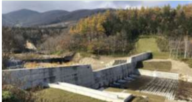
土石流から生命財産を守るため、砂防えん堤などの整備を行う。
