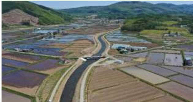
洪水から家屋や農地を守るため、河道掘削や堤防などの整備を行う。
