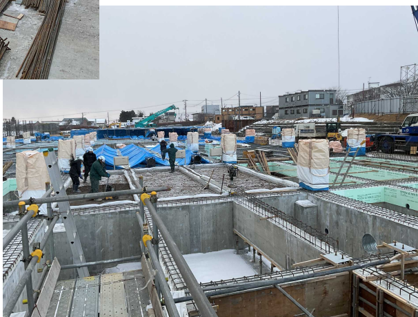
▼工事現場（執務室周辺）の様子 (令和7年1月15日時点)
